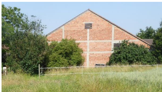
Abbildung 8: Gebäude des Bauernhofs.
